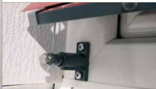
Seilabspannung Außenraffstore
